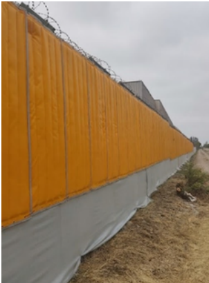
Cierre perimetral de obra
